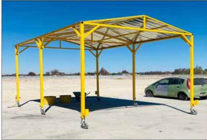
Segundo techo móvil para losa de extricación.
